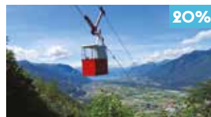
Teleferica Camorino - Monti di Croveggia Camorino www.teleferica-croveggia.ch
